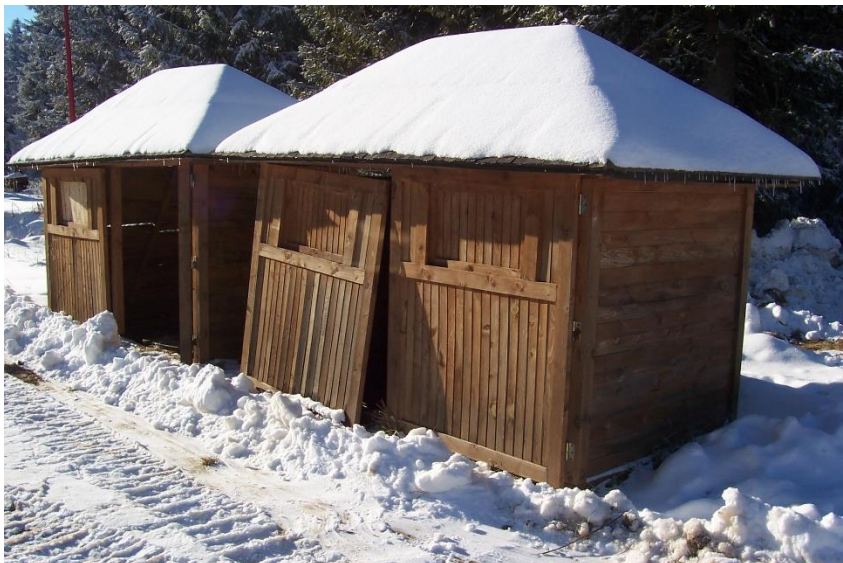
Илустрација 47. Контејнери 1.1 м 3 у посебној заштитној конструкцији
