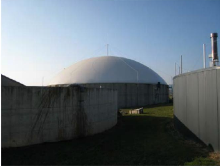
Фотографија 12: Постројење за биогаз / ферментацију са фолијарним резервоаром
